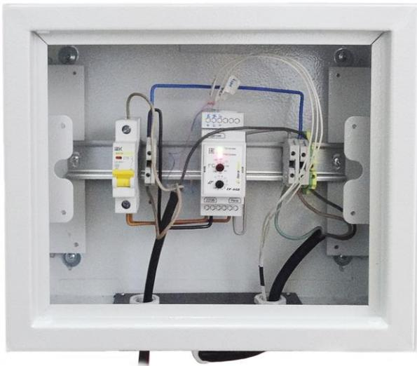
В щите управления расположен электронный терморегулятор для точной установки требуемой температуры. Инструкция по регулировке в приложении 2. Подготовка к работе щита управления описана в Приложении 1.
