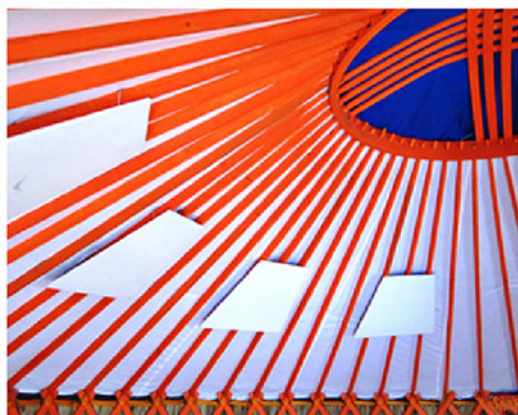
Греющие кассеты трапецивидной формы для обогрева юрты
